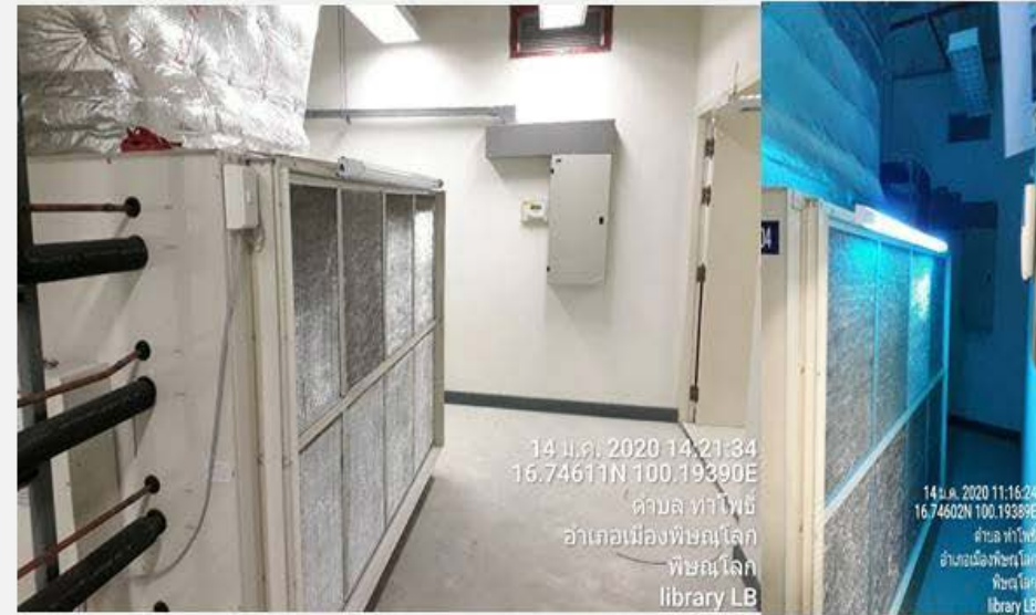
การติดตั้งหลอดรังสี UV-C ภายในห้องเครื่องปรับอากาศแบบรวมศูนย์ (AHU)
