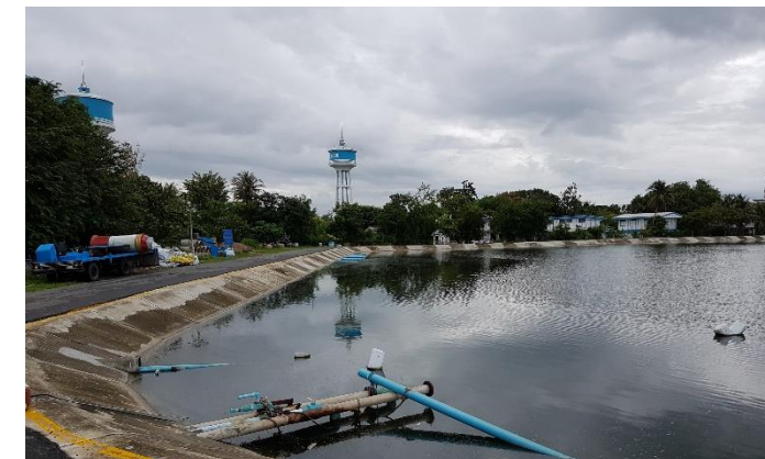
ระบบบำบัดน้ำเสีย
