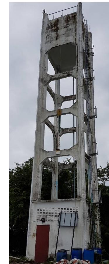
หอสูบน้ำทิ้ง
